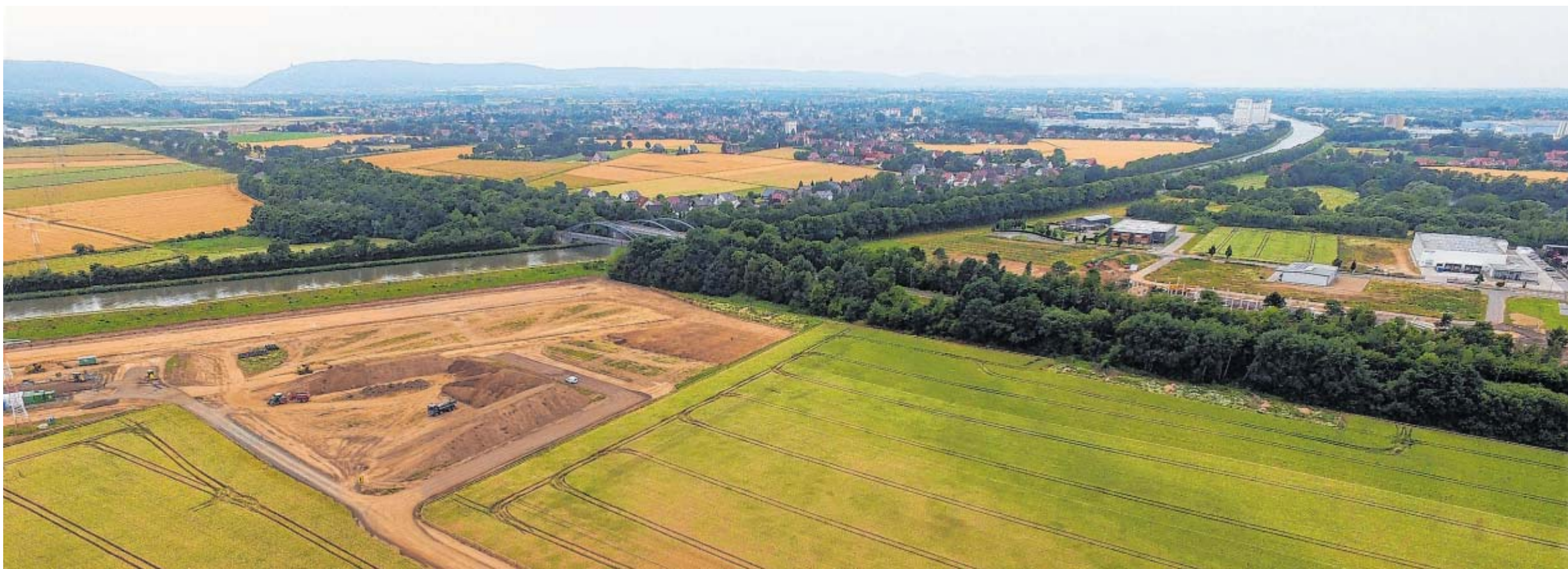
Aus der Vogelperspektive: Der Industriehafen ist noch in Sichtweite. Künftig sollen Containerschiffe und Lkw den Regioport ansteuern, Güterzüge könnten folgen. Der erste Bauabschnitt umfasst lediglich die deutlich sichtbar vorbereitete Fläche – der angrenzende Acker dient als Reserve für künftige Ausbaustufen.
